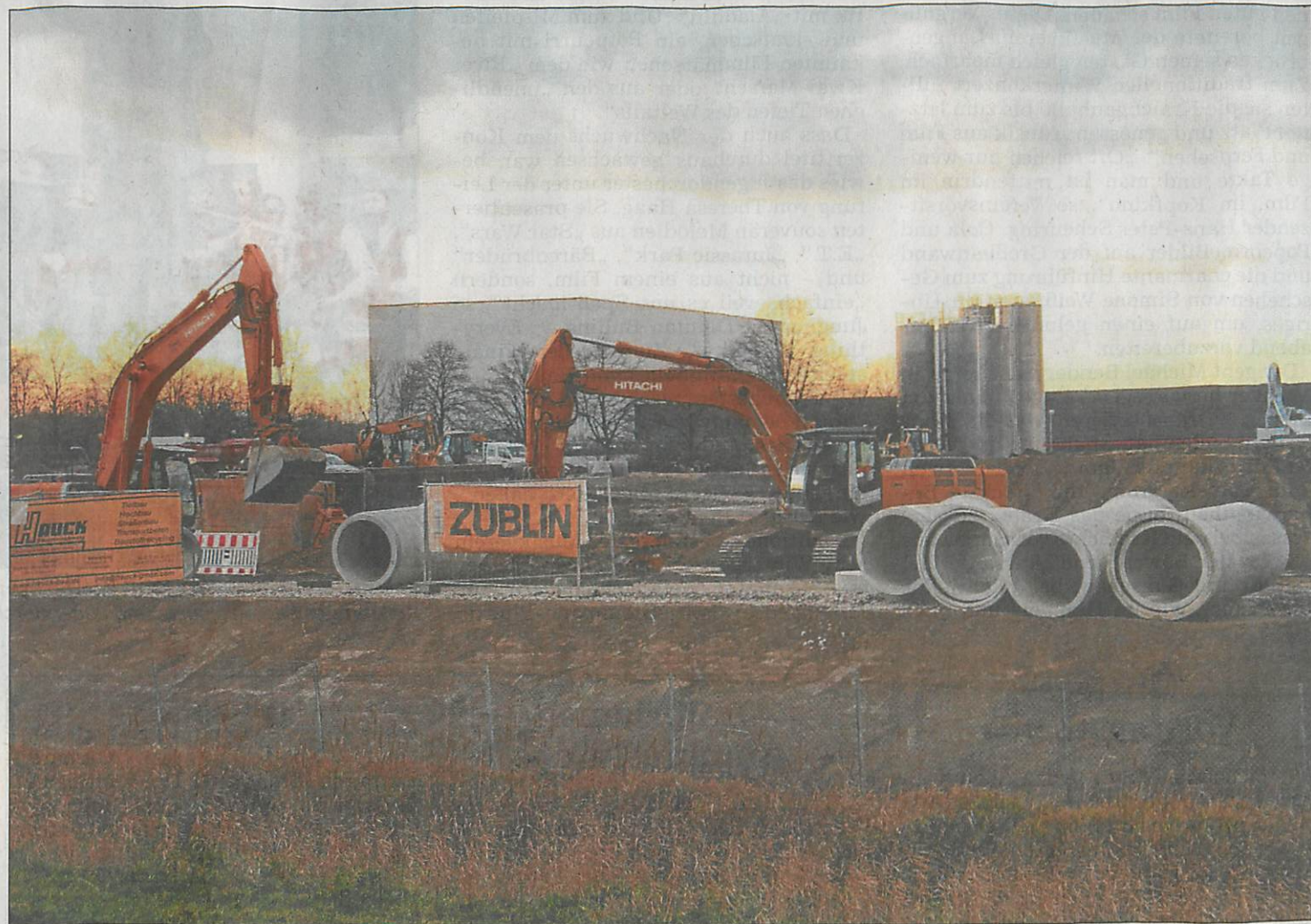
BAUEN FÜR BADER: Im Östringer Industriepark wird das Gelände für den Großversand, der 2017 von Pforzheim in die Kraichgaustadt umziehen wird, vorbereitet. Foto: psp
